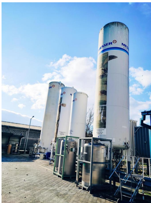
Сл. II.2: Резервоари за течен гас
